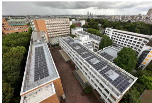
キャンパス屋上太陽光発電設備
