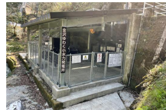
金沢ゆわく小水力発電所
