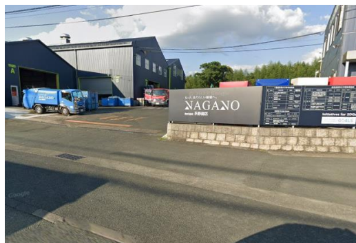
2023年3月に自家消費型太陽光発電システムを北部事業所に設置
