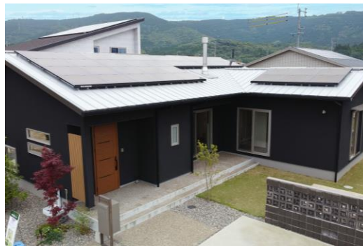
太陽光パネルの設置
