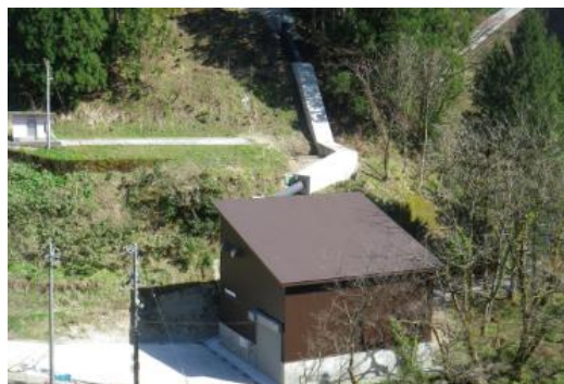
湯谷川小水力発電所
