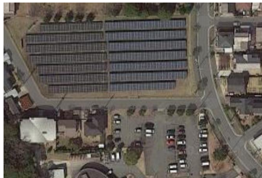
介護老人保健施設 伯鳳会プラザ 太陽光発電設備
