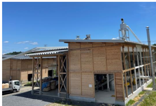
建物を木造にすることで炭素固定を 図った新工場
