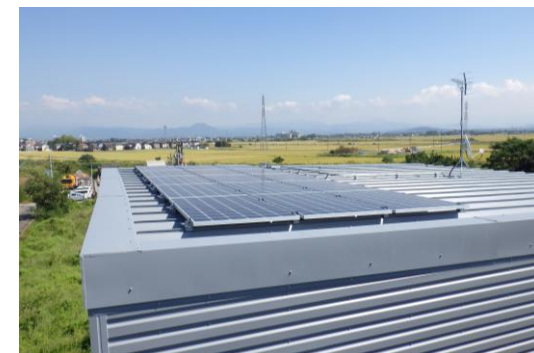
倉庫（太陽光発電機設置状況）
