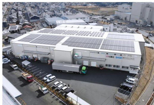
太陽光発電設備
