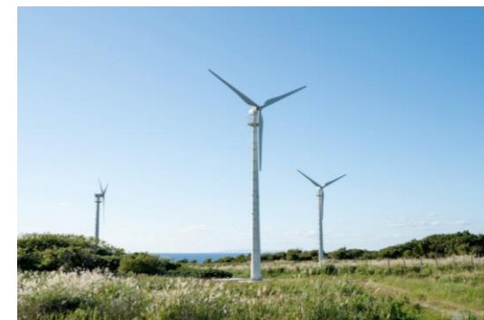
風力発電設備（北海道）
