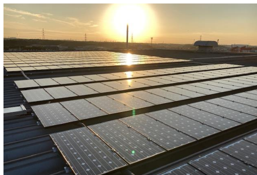
リユース太陽光パネルを設置 (2022年12月)
