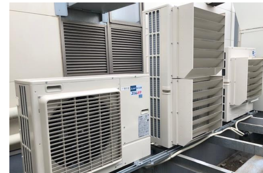
空調設備の更新
