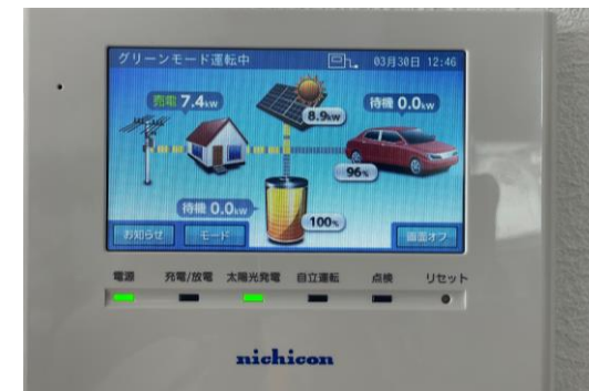
太陽光発電パネル・蓄電池・EV車の 電気の見える化
