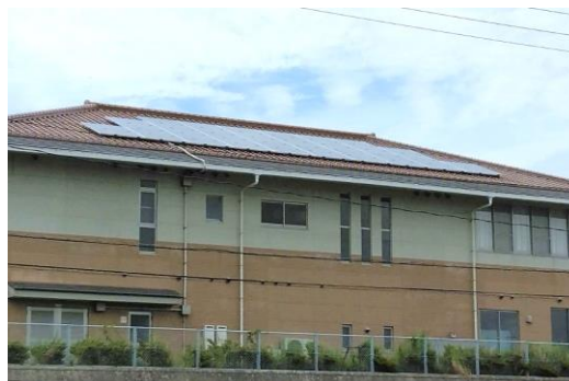
市立水防センター（防災拠点）への 太陽光発電導入
