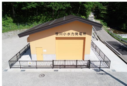
笹川小水力発電所建屋
