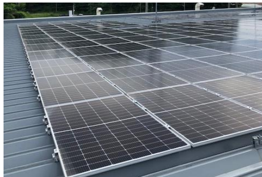
太陽光パネルの設置
