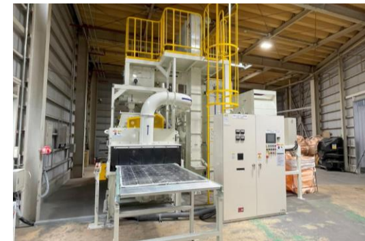
太陽光パネルリサイクル設備
