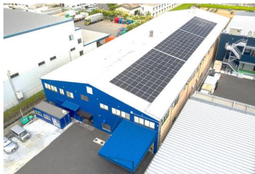
本社の太陽光発電設備
