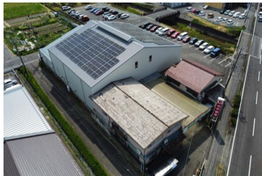
工場の屋上に太陽光発電機を設置
