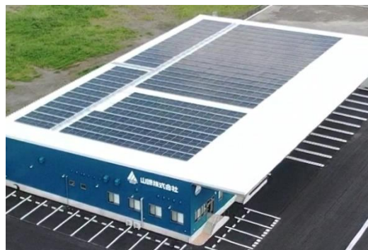
太陽光発電設備
