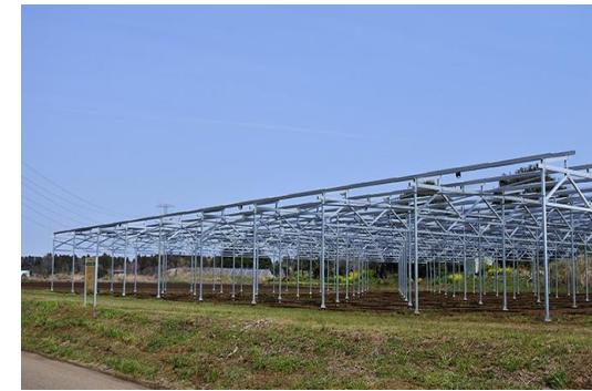
営農型太陽光発電設備 (ソーラーシェアリング)
