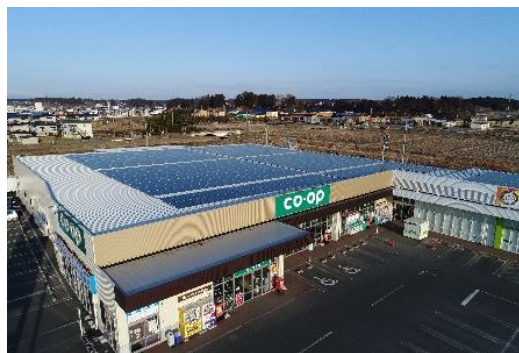
おいらせ店屋根上太陽光パネル
