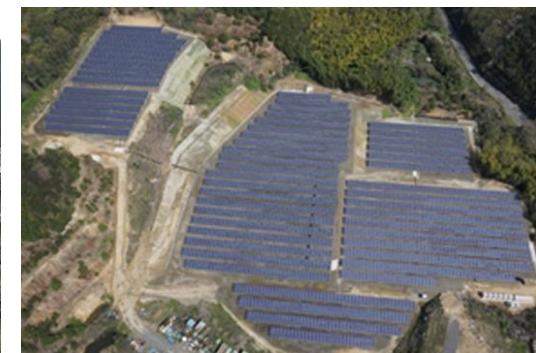
太陽光発電（岡山発電所）
