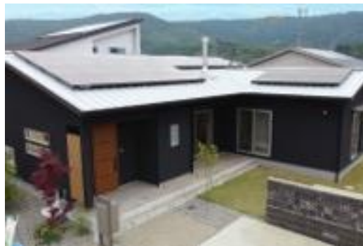
太陽光パネルの設置
