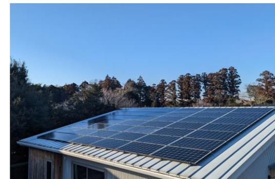
PV出力13.2kW、発電量16MWh/年
