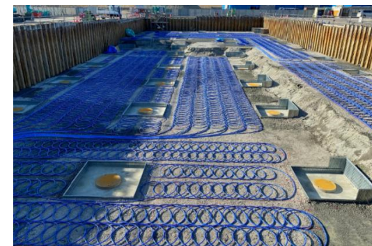
アクアイグニス仙台に設置された 地中熱のシステム
