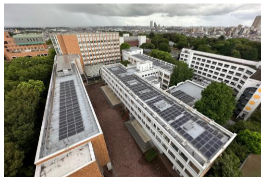
キャンパス屋上太陽光発電設備
