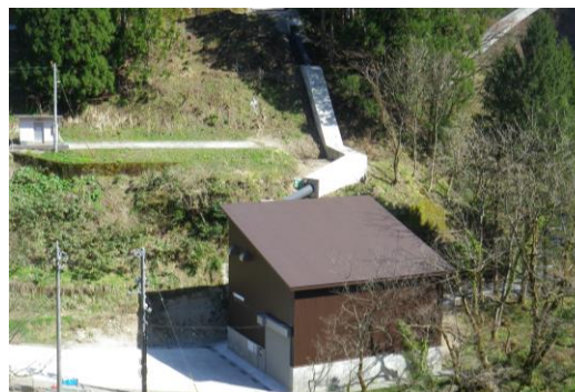
湯谷川小水力発電所
