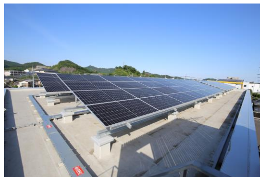
新社屋屋上に太陽光発電設備を設置
