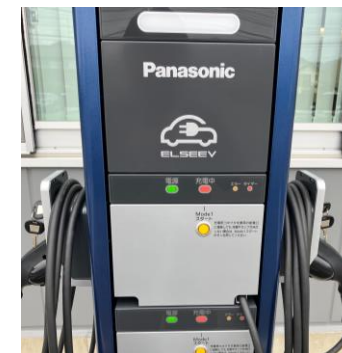
EV自動車用の給電スタンドを設置
