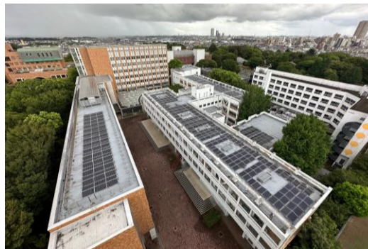
キャンパス屋上太陽光発電設備
