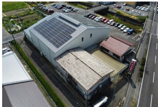
工場の屋上に太陽光発電機を設置
