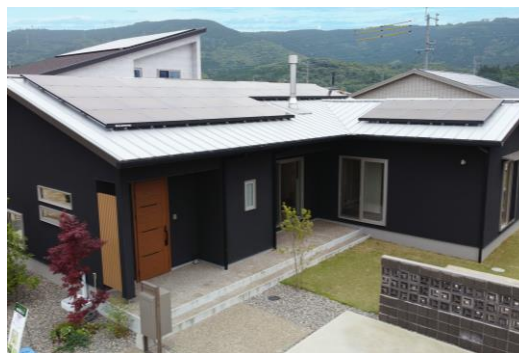
太陽光パネルの設置
