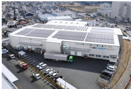
太陽光発電設備
