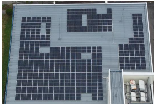
太陽光パネル
