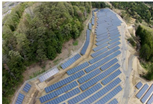
太陽光発電設備（福島県）
