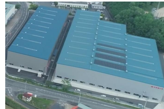
第二工場太陽光発電設備
