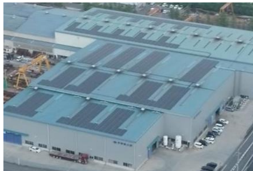
第一工場太陽光発電設備
