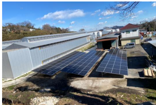
自家消費型太陽光発電（64.5kWh）
