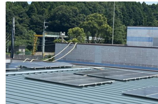
成田第2工場太陽光パネル屋根設置
