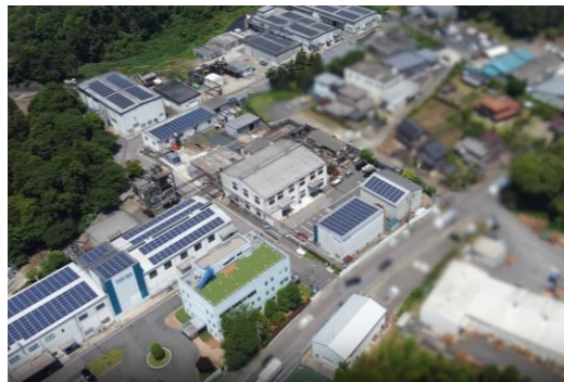
工場屋根に太陽光パネルを設置
