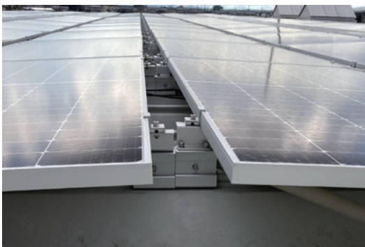
ならコープの事例。東西向け配置により朝夕発電量の増加をねらう。つかみ金具により東西に約3度の角度をつけている(左)。西方面を望む(右)。
