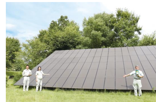
環境コミュニケーションセンターに 設置した太陽光パネル
