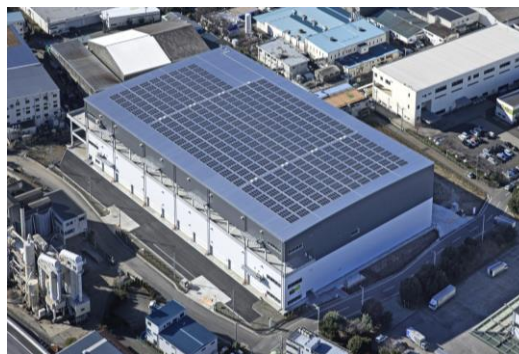
物流施設屋上の太陽光パネル
